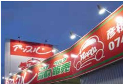
発光効率が良く高演色(Ra85)で看板を明るく照射。安定器設置不要、長寿命のため、高所の看板でも交換の手間を低減できます。
